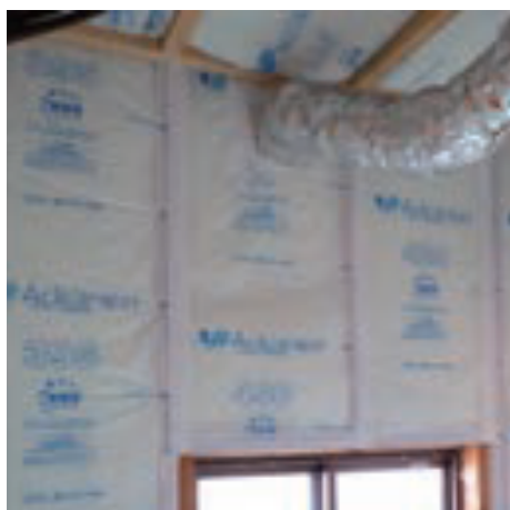
壁裏への 断熱材の施工
