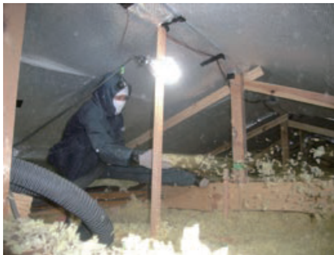
天井への 断熱材の施工
