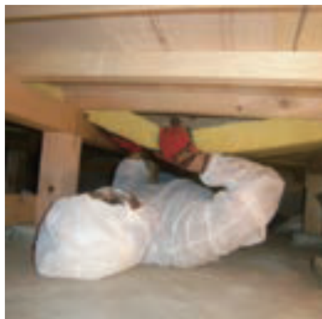
床下への 断熱材の施工
