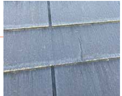
屋根は5年周期で点検、15～20年程度で葺き替えを検討すべきもの。機能回復に留めず、機能向上の提案もしていきたい
