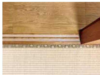
段差をなくしたり、手すりの設置の際、床や壁を剥がす作業が発生する。その際に断熱工事を実施すれば、大きなコストアップなしに断熱性能を提供できる
