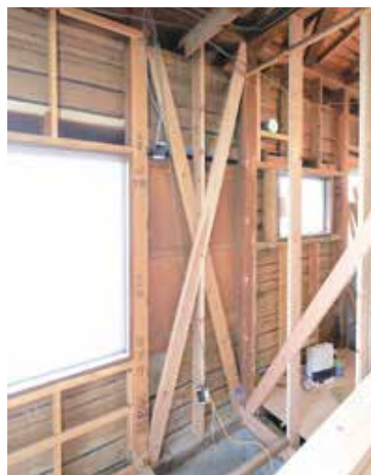
耐震補強は建物の構造や躯体に触れる工事になるため、断熱リフォームとの親和性が高い
