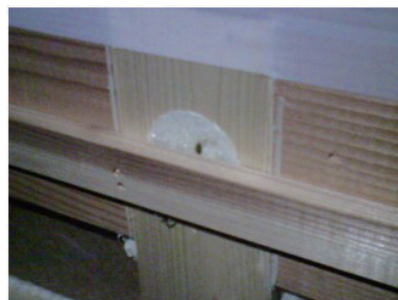
改修前検査時、熱橋箇所を確認（風建設 HP より）
