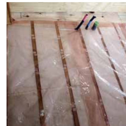
床断熱の例 (充填断熱)
