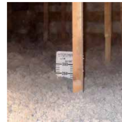
天井断熱の例 (吹付断熱)
