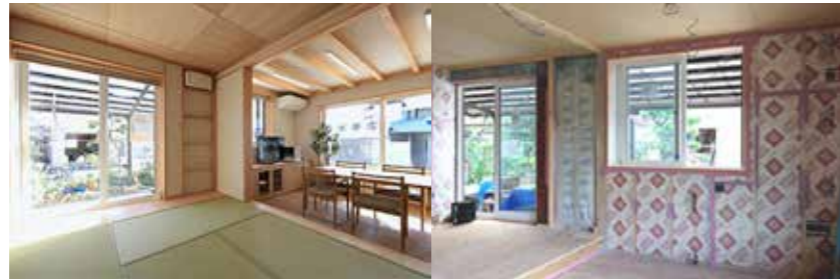
事務所敷地内にある築50年の店舗併用住宅の店舗部分を断熱リフォームし、「健康・省エネ改修体感ギャラリー」として公開。また事務所には屋根に10kwの太陽光パネルを設置し、自社で使うエネルギー消費量をほぼ賄うほか、2台の電気自動車や蓄電池に貯めることで災害時の非常用電源として使用できるように。電気自動車での客先への訪問によって、省エネや環境意識の高い事業者であることのアピールにもつなげています (右は施工時。実際の気密性を確保できる実践の機会として活用)
