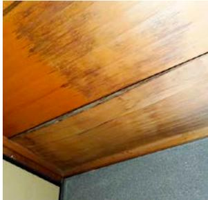
雨漏りによる木部の腐食
