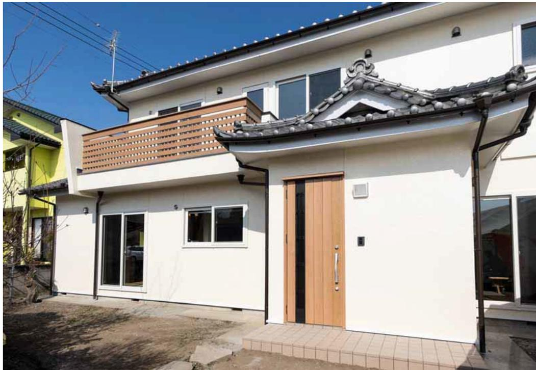
反りのある独特な屋根形状。既存の瓦・屋根は補修程度でそのまま使用し、外壁は仕上げ直してリフレッシュ。
