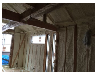
断熱材吹付け
