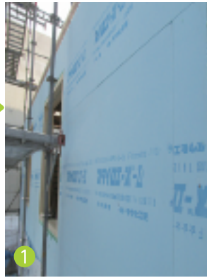
外壁の屋外側（左）と屋内側（右）それぞれに断熱材を施工。
