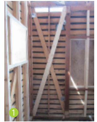
1階の東南角付近の耐力壁は、筋交いをたすき掛けにして耐震性を高めた。
