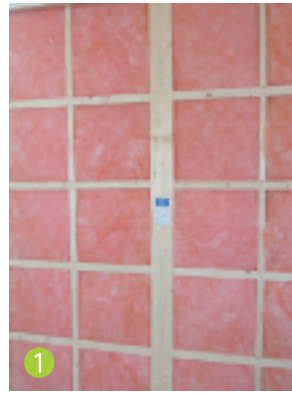
外壁の屋外側（左）と屋内側（右）それぞれに断熱材を施工。
