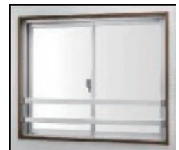
▲手すりの設置
