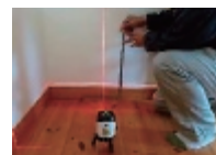
床の傾きを計測
