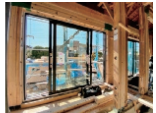
高性能樹脂サッシ取付
