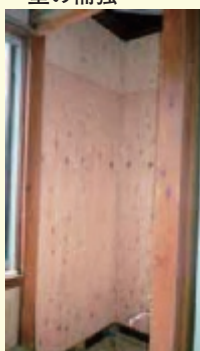
■構造用合板による壁の補強
