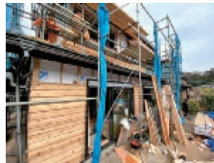
外壁通気工法化
