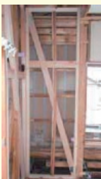
■筋かいの新設
