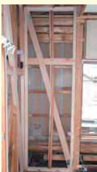
■筋かいの新設
