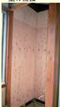
■構造用合板による壁の補強
