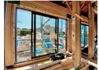
高性能樹脂サッシ取付
