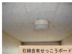
アスベスト含有建材の使用部位例
