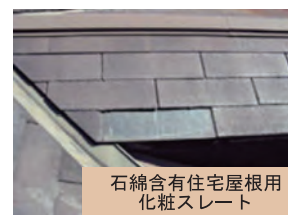
アスベスト含有建材の使用部位例
