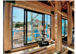
高性能樹脂サッシ取付
