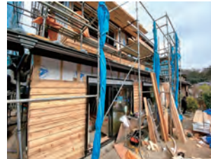
外壁通気工法化
