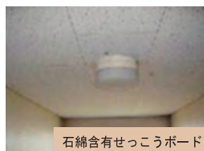
アスベスト含有建材の使用部位例
