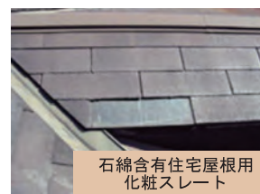
アスベスト含有建材の使用部位例
