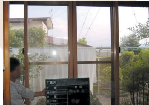
写真6-2 リフォーム工事後の「後付樹脂サッシ」の内窓がついた窓です
