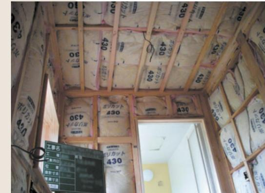
写真6-4 リフォーム工事中。断熱材が壁・天井にぎっしり充填されています
