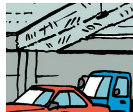
吹き付け石綿の例
