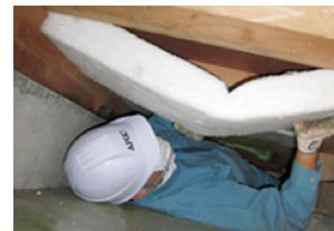
建物全体を断熱材で覆い、室内の断熱性・気密性を高めていきます。
