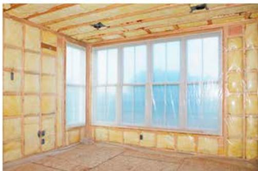
既存の外壁の断熱材を撤去し、敷込断熱等を施工
