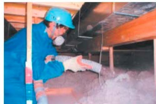
既存天井をそのままに吹込断熱断熱等を施工
