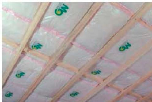
既存天井の断熱材を撤去し、敷込断熱等を施工
