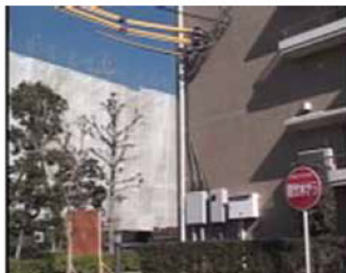
b. 低圧架空引き込み例
