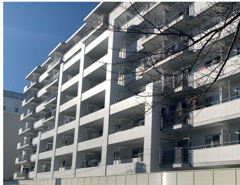
アウトフレーム補強事例
