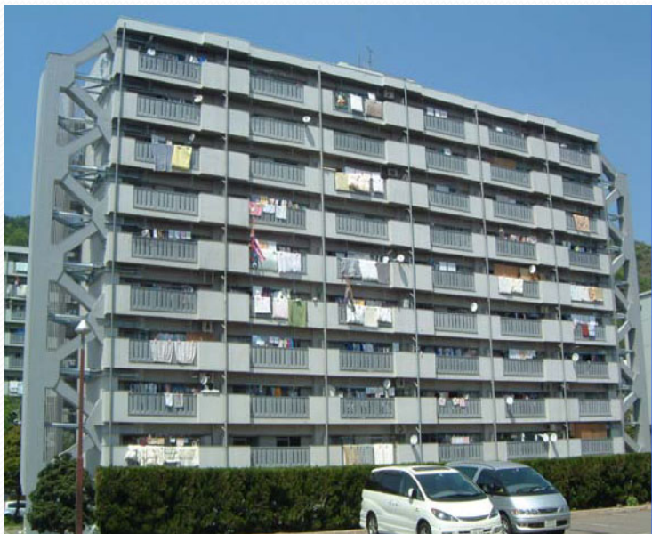
バットレス補強事例
