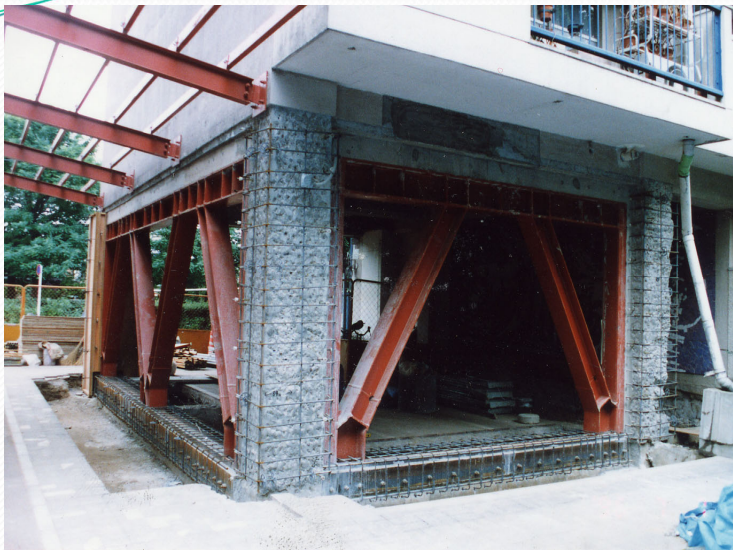
鉄骨ブレース補強事例
