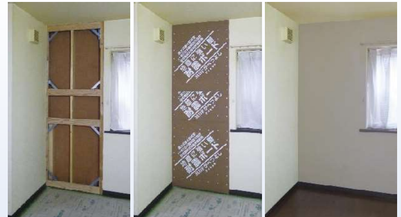
内壁補強キットの施工例
