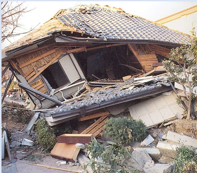
老朽化により全壊
